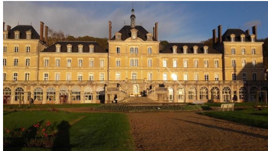
©Bâtiment «Ermitage» - Notre-Dame de Montligeon
